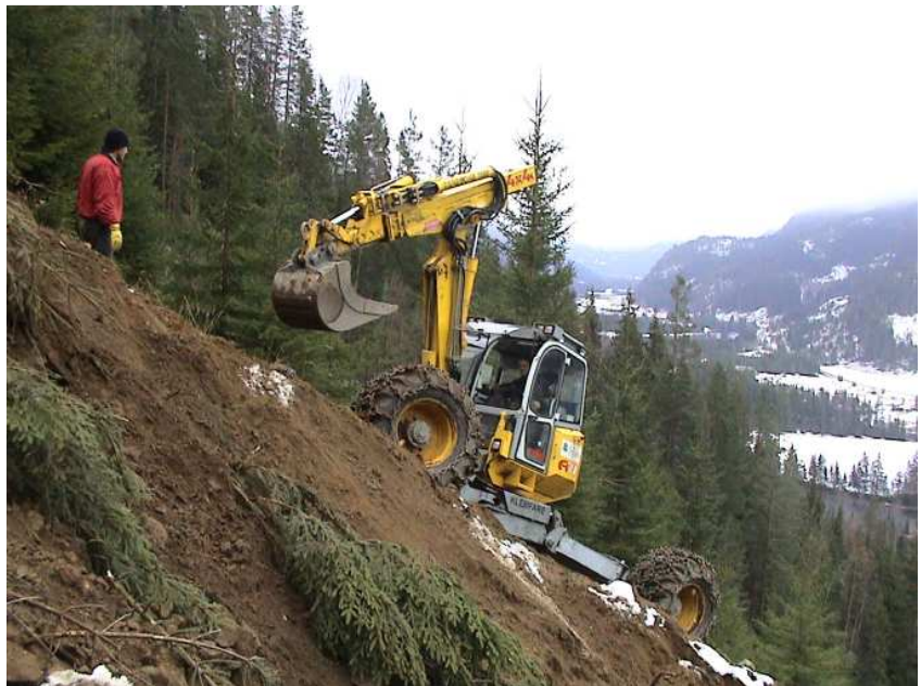
Rørgate lagt i 37 graders helning
