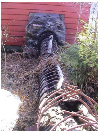
Rester av rørgate i tre
