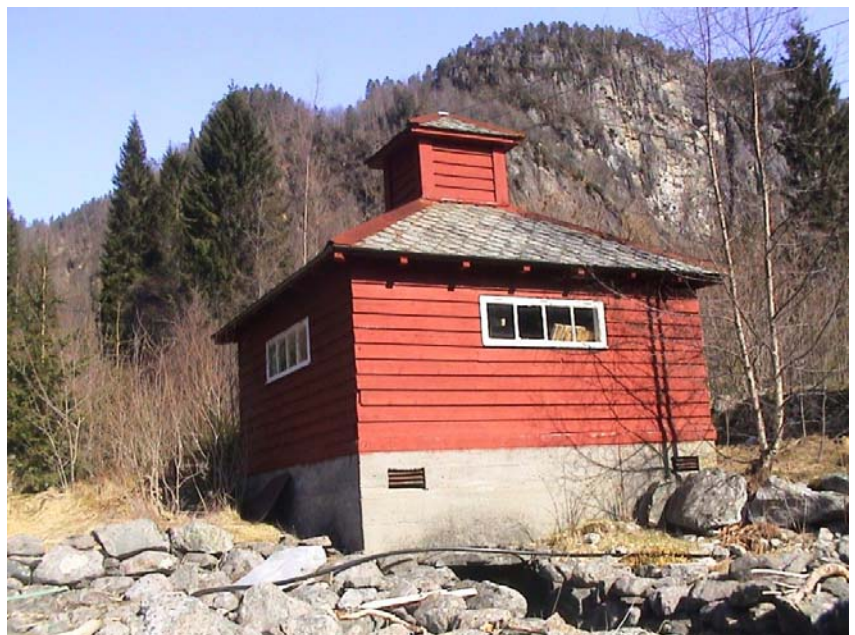
Kraftstasjon nede ved sjøen og på gården
