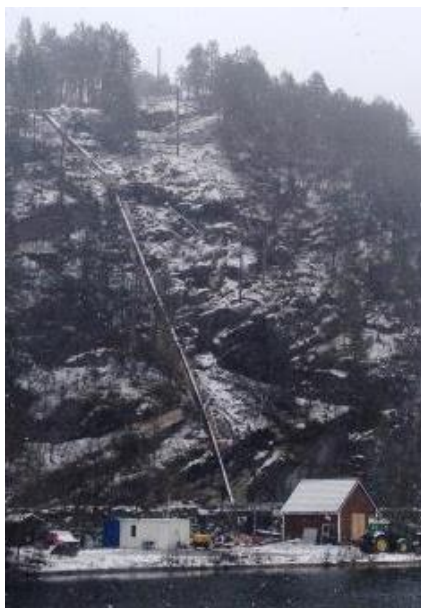
Bratt rørgate helikopter montert
