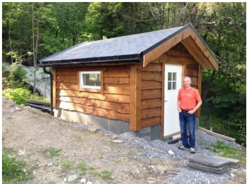
Stasjonshuset med elva i bakgrunn
