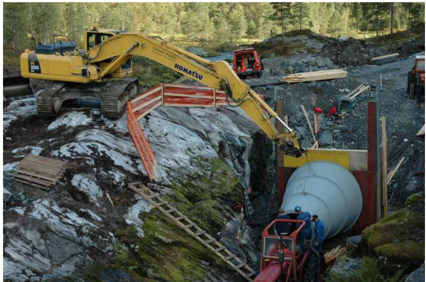
Installasjon av konus sep. 2007
